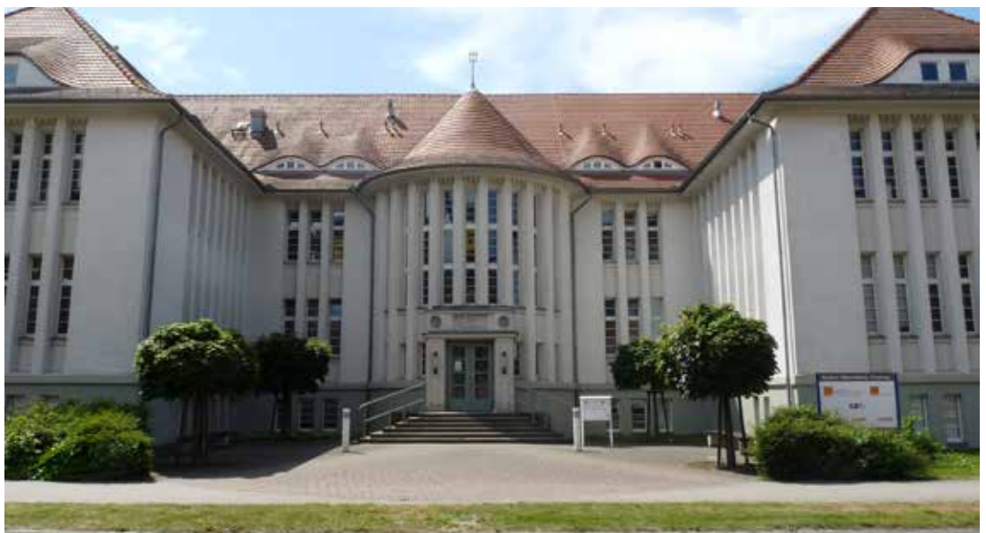
Abb. 7 | Ehemaliges Verwaltungsgebäude der Neptunwerft
